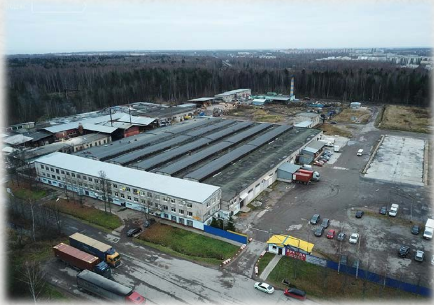
Производственная площадка «Мартышкино»
