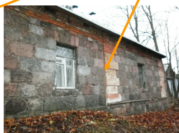
Следы достройки здания фермы корпуса 10а.
