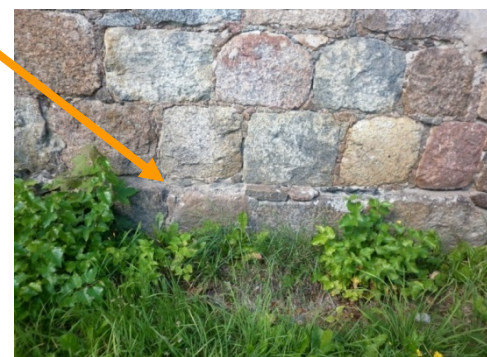
Слой из гранитных плиток
