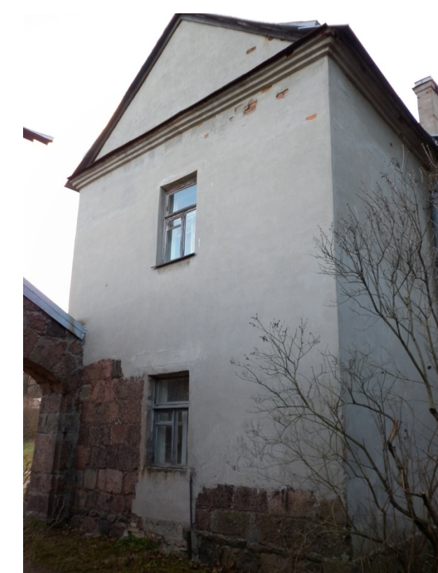
Надстроен кирпичный второй этаж корпуса 10.
