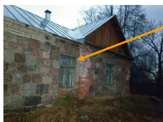
Следы достройки здания фермы корпуса 10а.
