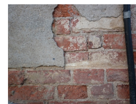
Старая плотная и новая «рыхлая» кирпичные кладки корпусов 10 и 10а.
